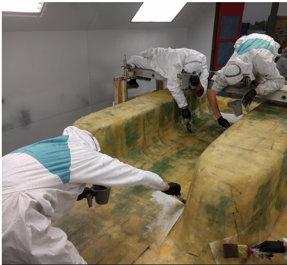
Des membres à l'œuvre lors d'une opération majeure pour le moule de la coque du bas
